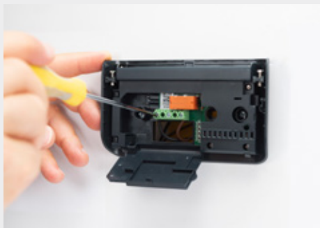
7. Collega i conduttori alla morsettiera del relè del cronotermostato
