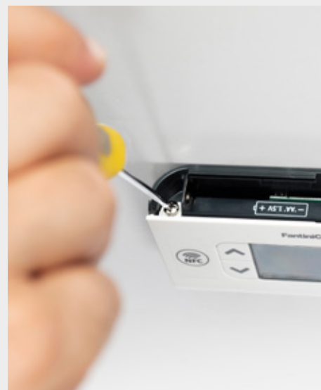
10. Ora puoi serrare le due viti di tenuta
